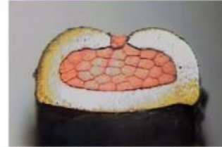
Fehler: Crimpbereich offen und überfüllt. Zuordnungsfehler: Der Nennquerschnitt der Leitung ist für den Crimpkontakt zu groß!
